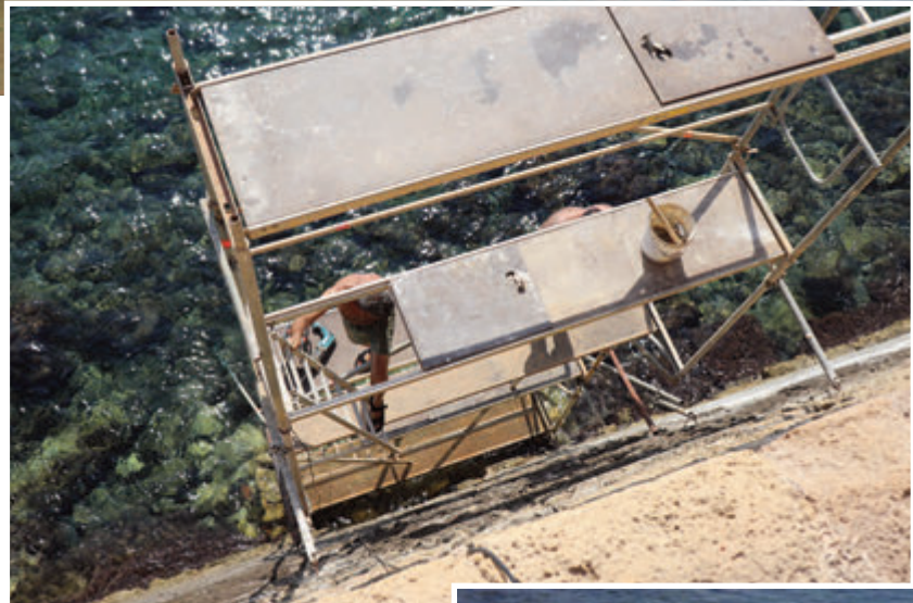
Στην αποκατάσταση της τρύπας που έχει σχηματιστεί στο ανατολικό τμήμα του προμαχώνα Mocenigo προχωράει συνεργείο της Εφορείας Αρχαιοτήτων Χανίων.
