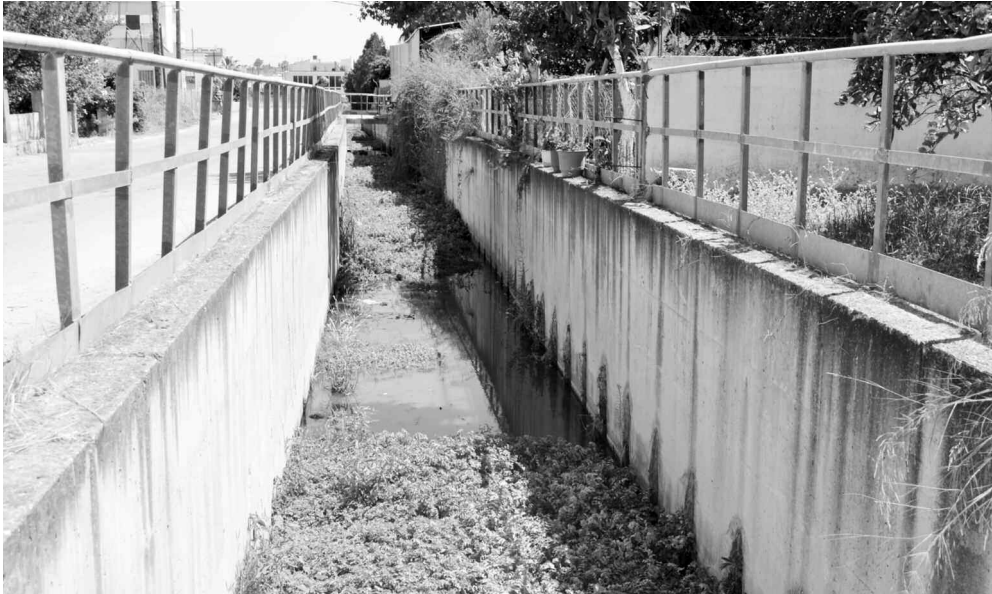
Το συγκεκριμένο έργο πρόκειται να βάλει τέλος στις τριτοκοσμικές εικόνες στο Καμίνι Σούδας με τα λύματα να καταλήγουν στον ανοιχτό αγωγό ομβρίων υδάτων, πρόβλημα που είχαν αναδείξει τον περασμένο Σεπτέμβριο τα "Χ.Ν.".
